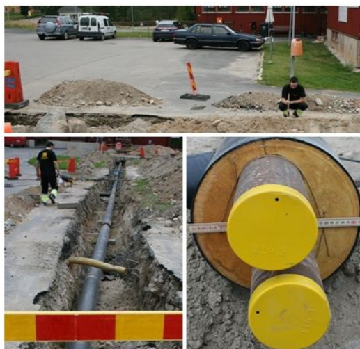
Рисунок 5. Документирование положения и размеры трубы
